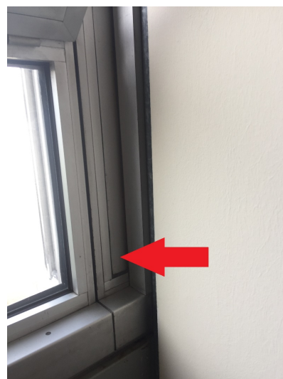
Halb verdeckt durch Zwischenwand
